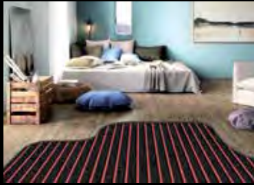
CHAUFFAGE AU SOL
